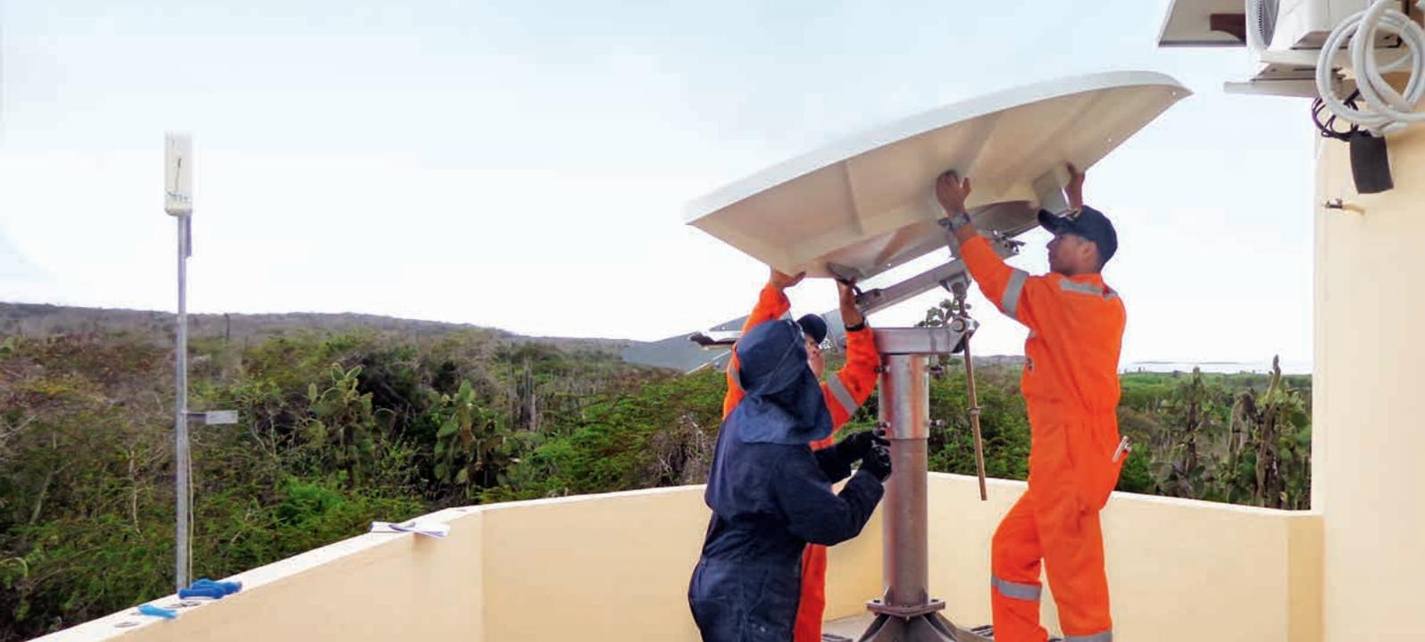
在加拉帕戈斯群岛的圣克鲁斯岛（厄瓜多尔）放射性核素台站 RN24 安装甚小孔径终端设备。
