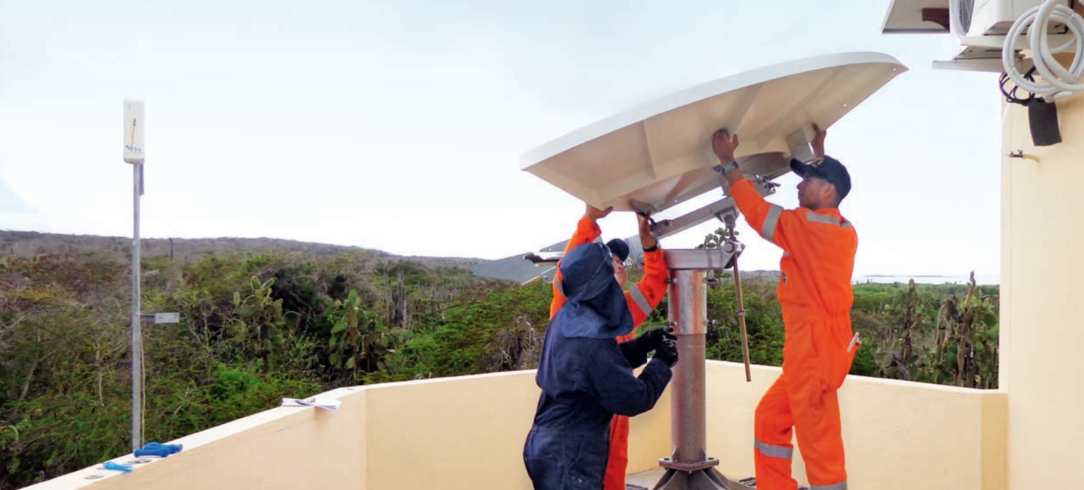
Установка оборудования VSAT на радионуклидной станции RN24 (остров Санта-Крус, Галапагосские острова, Эквадор).
