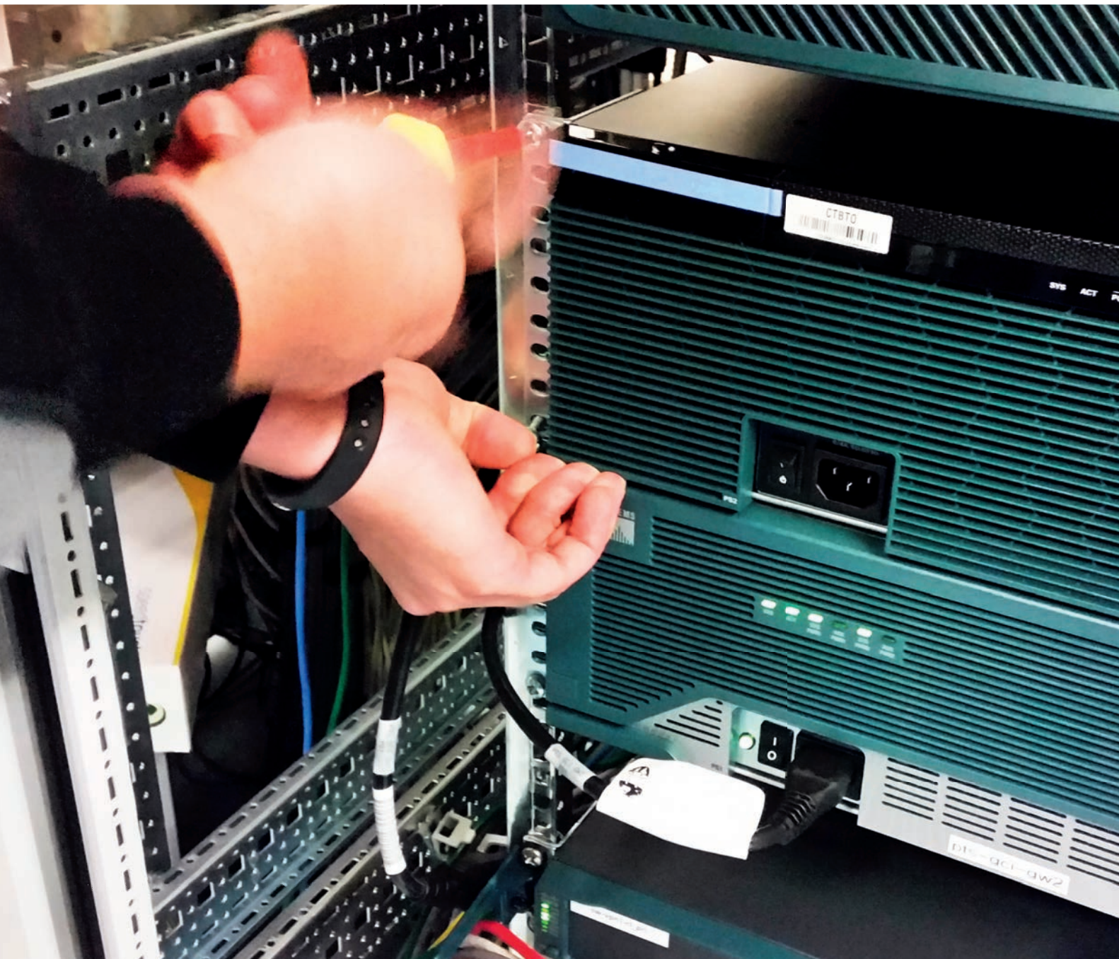
Установка нового оборудования ИГС в компьютерном центре в Вене.
