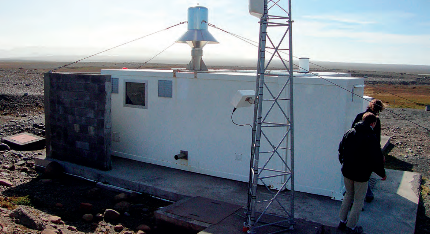
Station de surveillance des radionucléides RN30 de Port-aux-Français, aux Kerguelen (France), dont le système de détection des gaz rares a été certifié en 2012.
