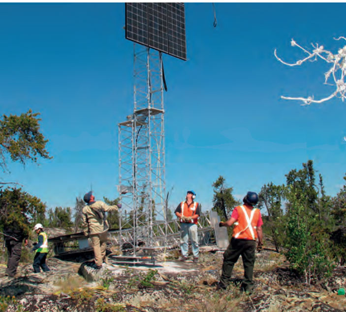
Travaux de mise à niveau à la station composite PS9 du réseau primaire de surveillance sismologique, à Yellowknife, dans les Territoires du Nord-Ouest (Canada). Gauche: Mise en place de panneaux solaires. Droite: Installation de l'enceinte du matériel.
