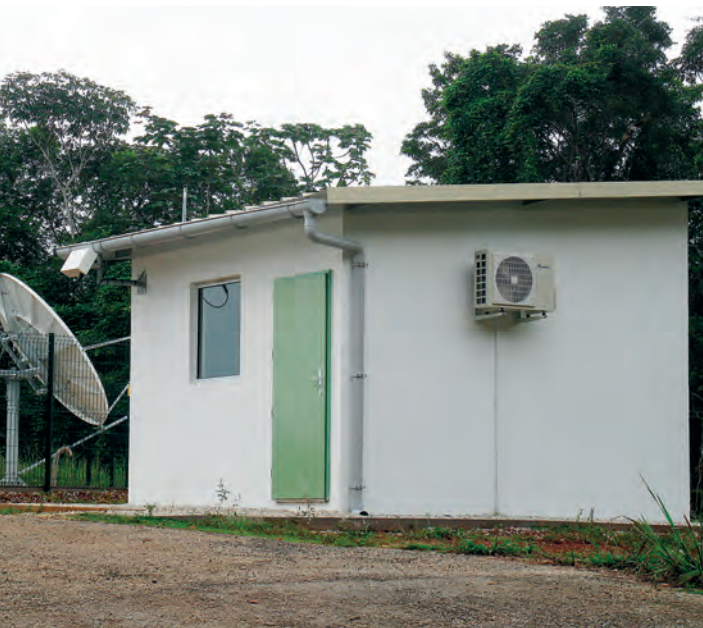
Station du réseau auxiliaire de surveillance sismologique AS33 à la Montagne des Pères (Guyane française), certifiée en 2012.
