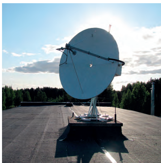
Antenne de microstation terrienne à la station du réseau auxiliaire de surveillance sismologique ASB2 de Kirov (Fédération de Russie).
