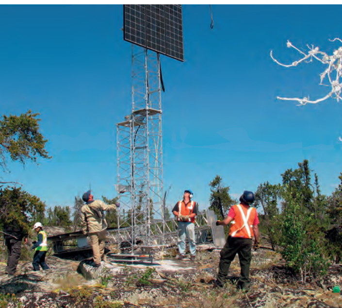
加拿大西北领地黄刀镇基本地震阵列台站 PS9 的升级换代工作。左侧：安装太阳能电池板。右侧：安装设备外壳。
